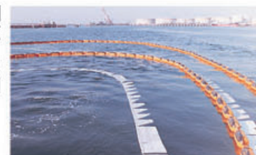
オイルフェンスを併用し油を回収
