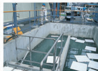
油水分離槽の浮上油の回収に
