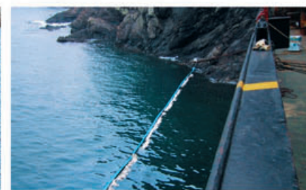
両端を固定して海岸線沿いの油を回収
